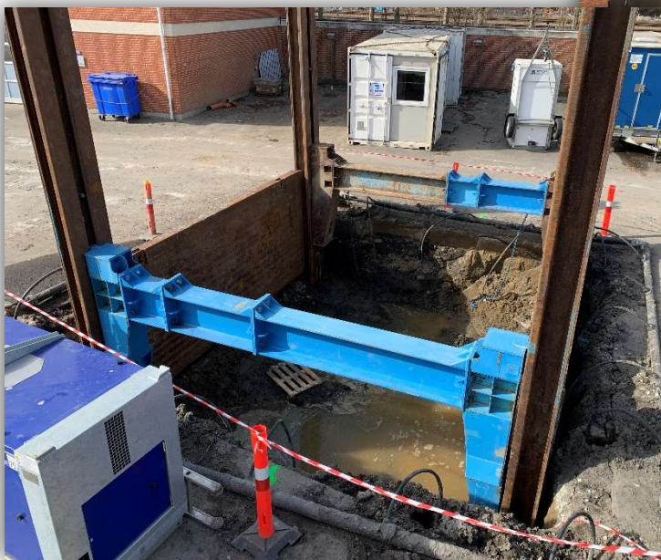
Etablering af boregrube til spildevandskorridor mod vest under baneterrænet
