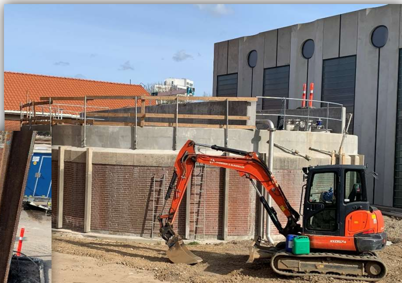
Færdigt låg på slamlagertank
