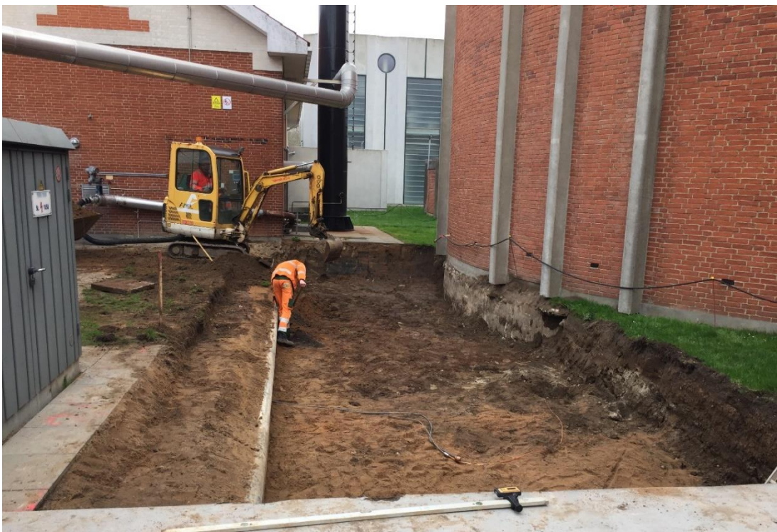
Klargøring af fundament til ny gasmotor
