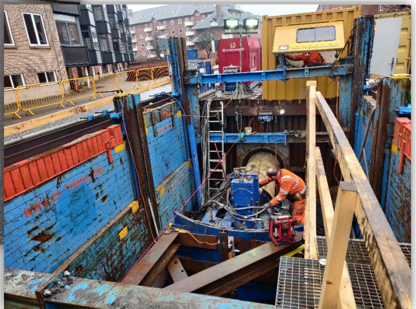
Tunnelering af ledning i Valløesgade i Østbyen
