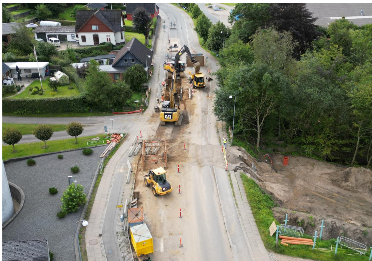
Kloakseparering i Egtved
