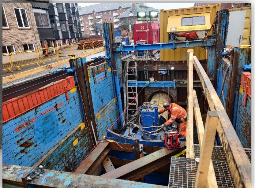
Tunnelering af ledning i Valløesgade i Østbyen
