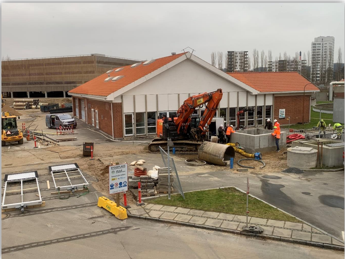
Montering af spjæld i bygværket til spildevandskorridorer
