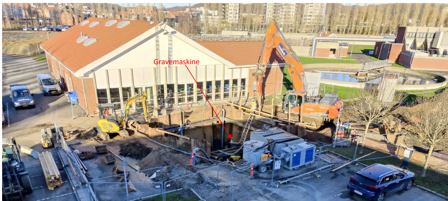
Nyt indløbsbygværk på Vejle Renseanlæg
