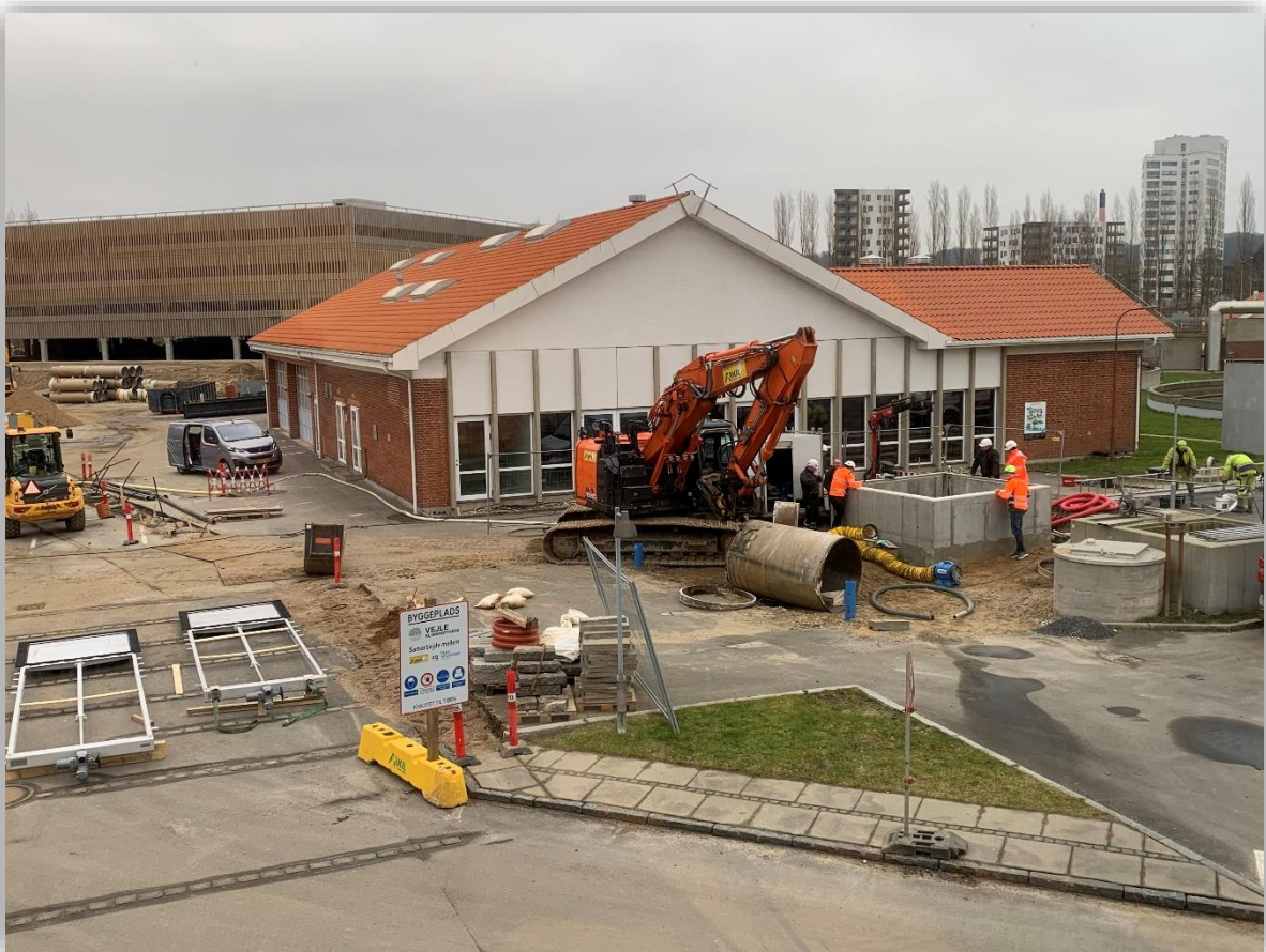
Montering af spjæld i bygværket til spildevandskorridorer
