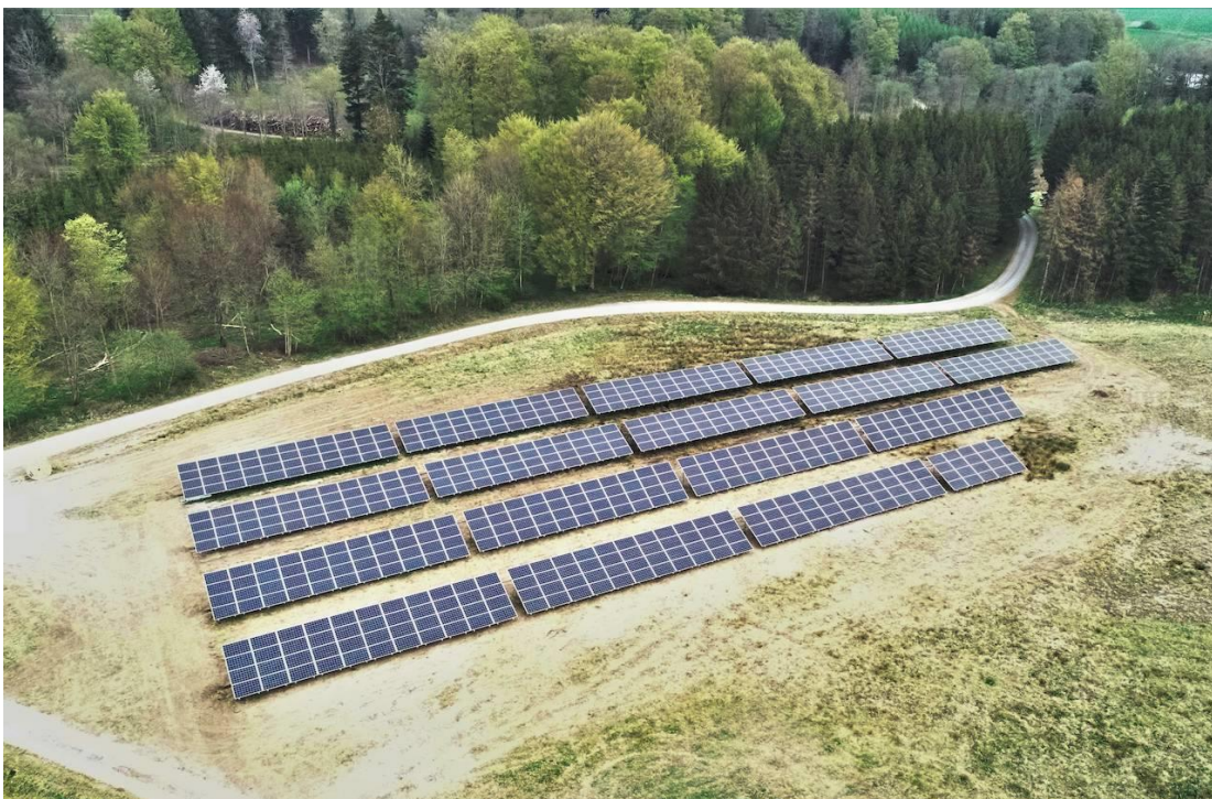
Nyt solcelleanlæg ved Haraldskær Renseanlæg
